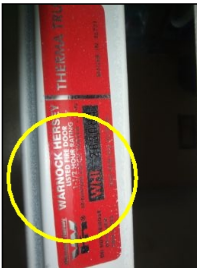
1 1/2 hour fire rating on door
